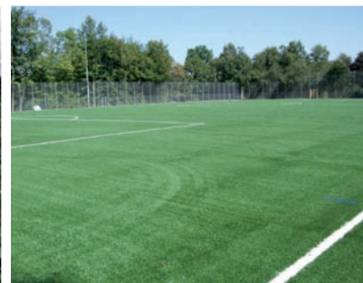
13 | Fertig verlegter Platz vor Einbringen der Füllkomponenten
