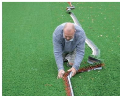
8 | Passschneiden der Kunstrasenkanten
