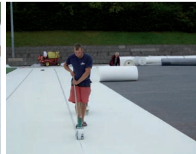
5 | Verschweissen der Bahnenstöße mit kleberbeschichtetem Tape
