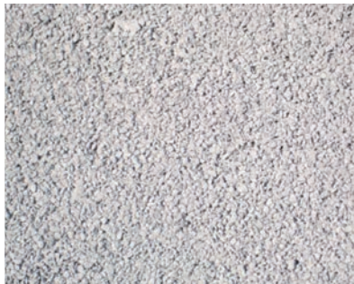
2 | Ansicht der Schotteroberfläche
