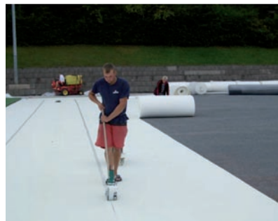
5 | Soldadura de los rollos con cinta adhesiva
