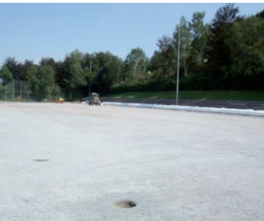
1 | Subsuelo con superficie de grava
