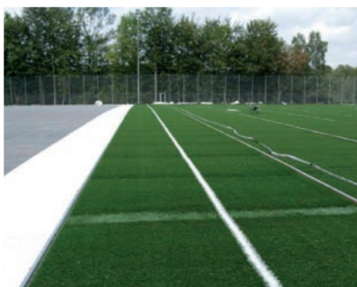
7 | Instalación del césped artificial con línea central integrada
