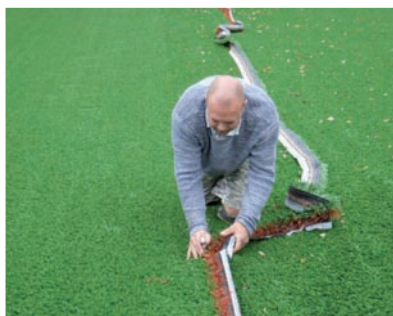
8 | Corte de los bordes del césped artificial
