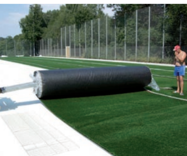
6 | A mesterséges gyeprétegek telepítése a ProGame ütécscillapító alátétekre
