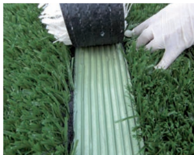
12 | Fissaggio delle linee
