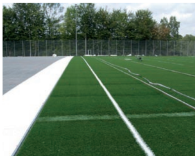
7 | Installazione del manto di erba sintetica con linea mediana integrata
