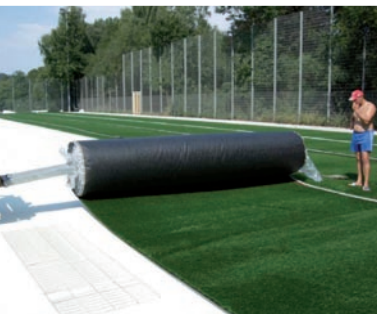
6 | Installazione del manto di erba sintetica su shock pad ProGame
