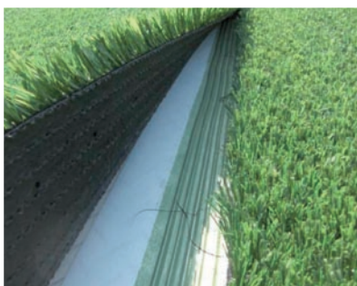
11 | Нанесение на дерн слоя ворса и 2-компонентного клея
